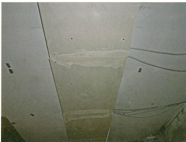
2 Brandschutztechnische Bekleidung eines Stahlträgers.
