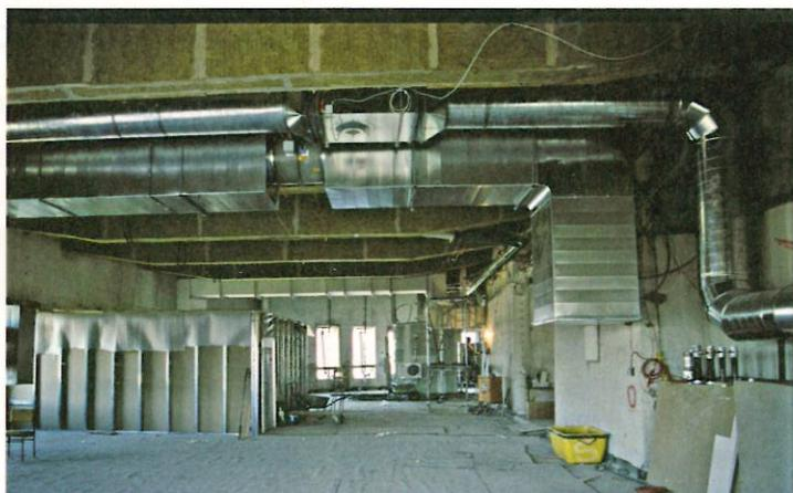
**5** An die Deckenplatten und Stahlträgern wurden Steinwolleplatten zur Verbesserung des Feuerwiderstands nachträglich angebracht, bevor die Trockenbauunterdecke ohne Brandschutzanforderungen eingebaut wurde.
