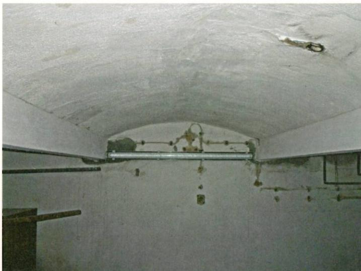
3 Brandschutztechnische Bekleidung mit Putz.
