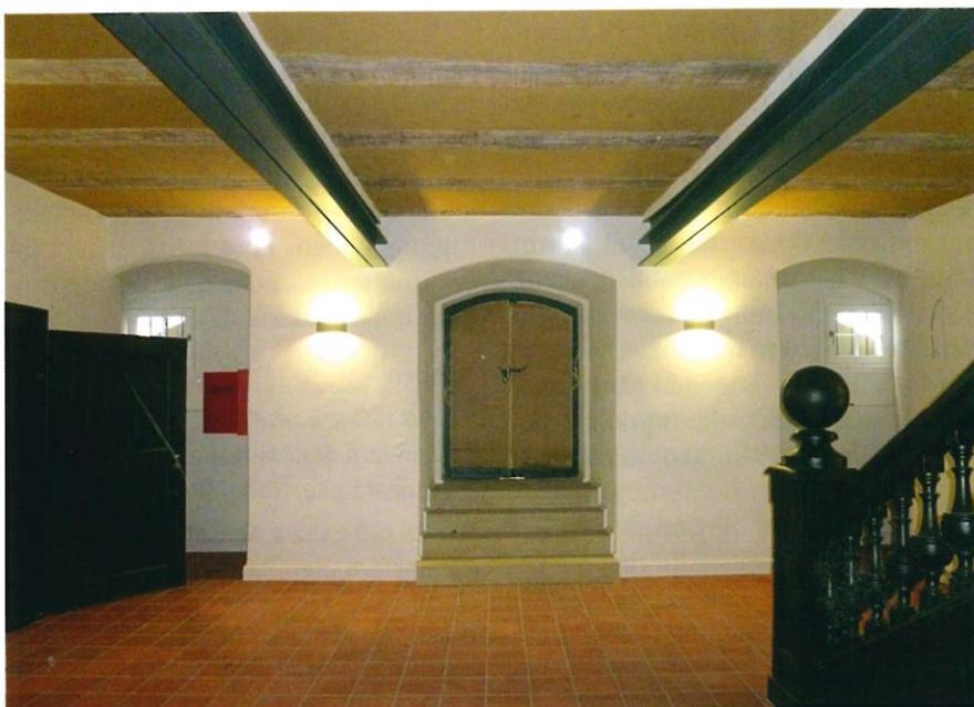
Abb. 1: Zulassungskonform beschichtete Stahlträger in einem Schlossgebäude (Foto: Prof. Gerd Geburtig)
