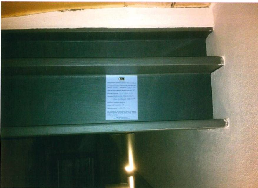
Abb. 2: Die Kennzeichnung erfolgte korrekt entsprechend dem abZ. (Foto: Prof. Gerd Geburtig)
