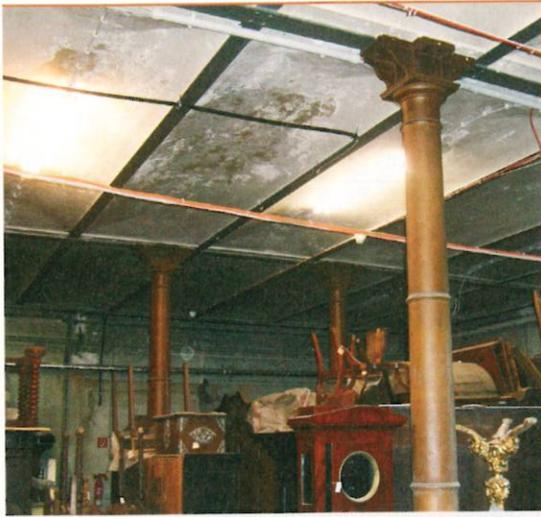
Abb. 3: Diese sich aufgrund der klimatischen Bedingungen in den Depoträumen auflösende Bestandsbeschichtung ist nicht mehr ausreichend leistungsfähig.
