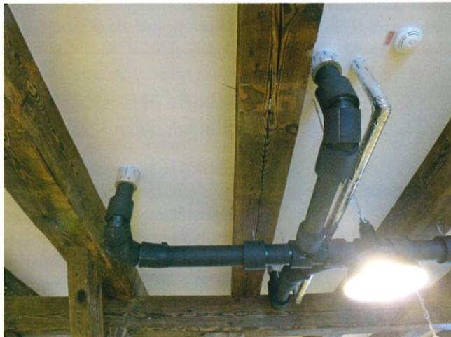
Abb. 4: Abschottung in einer bestehenden Holzbalkendecke
