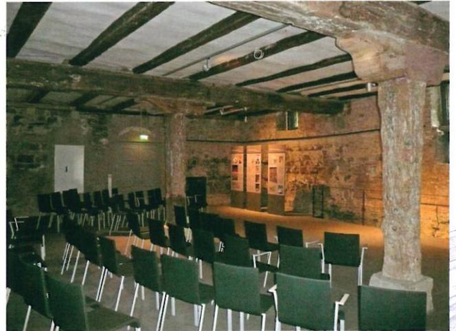
Abb. 5: Hölzerne Tragkonstruktion verblieb – richtig nachgewiesen – unbelkleidet in dem mehrgeschossigen Gebäude
