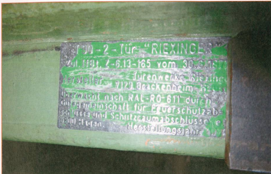
Abb. 9: Feuerbeständiger Feuerschutzabschluss mit bauaufsichtlicher Zulassung aus dem Jahr 1977
