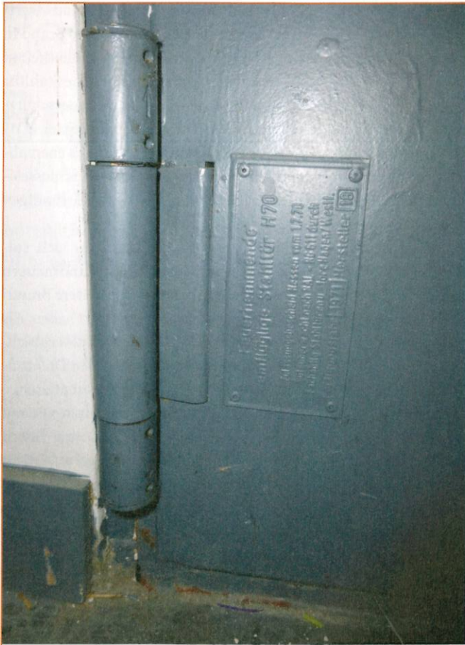
Abb. 3: Kennzeichnung der feuerhemmenden Stahltür aus dem Jahr 1970
