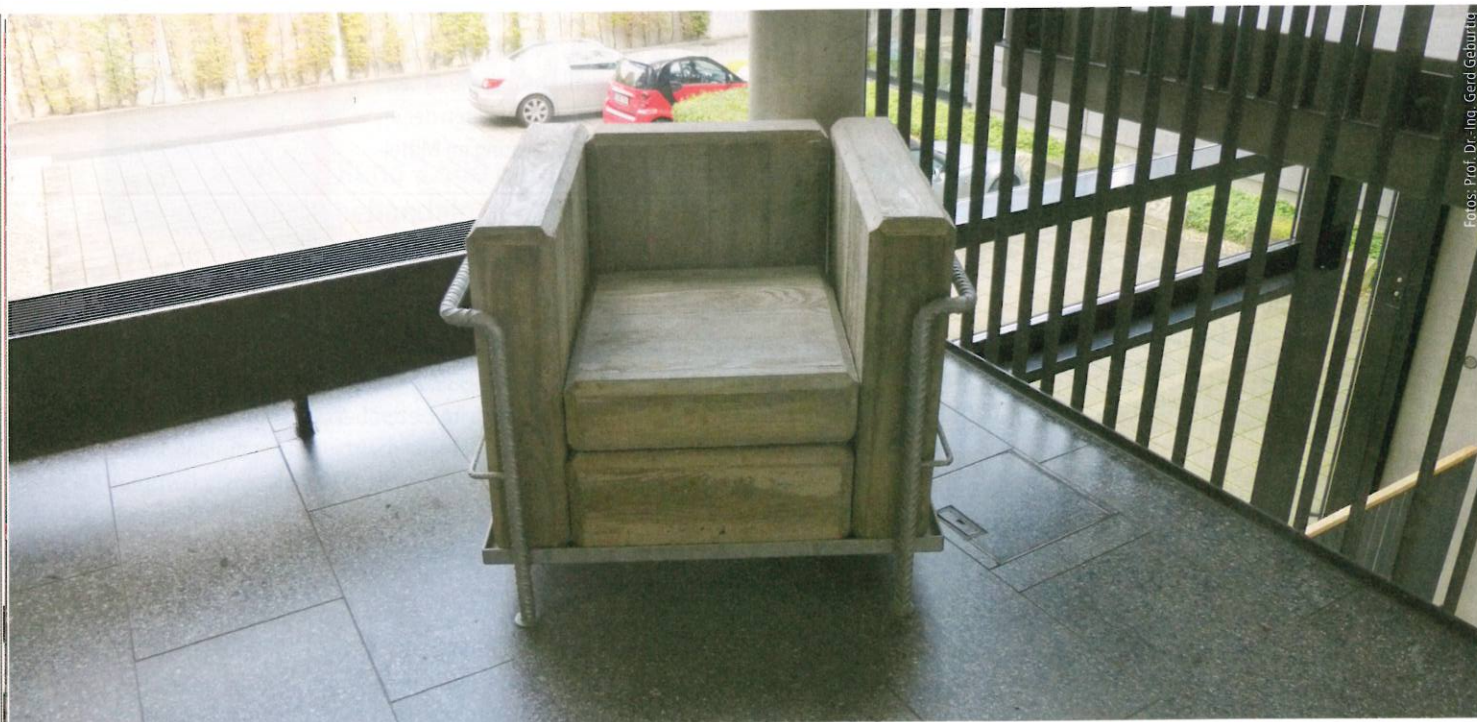
Abb. 1: Brandlastfreiheit auf die harte Tour: Betonsessel in einem notwendigen Treppenraum.
