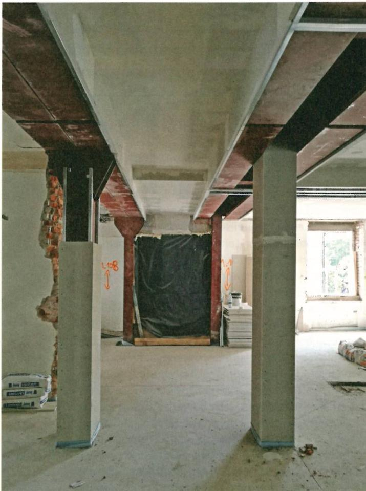
2 Massive Bestandsdecke und Stahlkonstruktion während der Ausführung.
