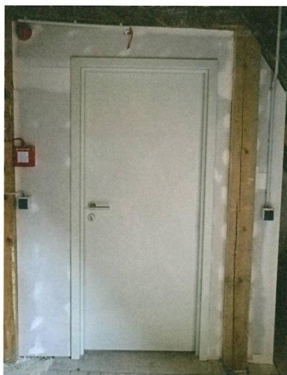
5 Neuer Öffnungsabschluss nach der brandschutztechnischen Sanierung.
