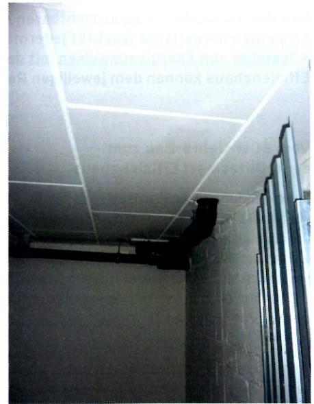
Bild 4 Neue Kellerdeckendämmung
