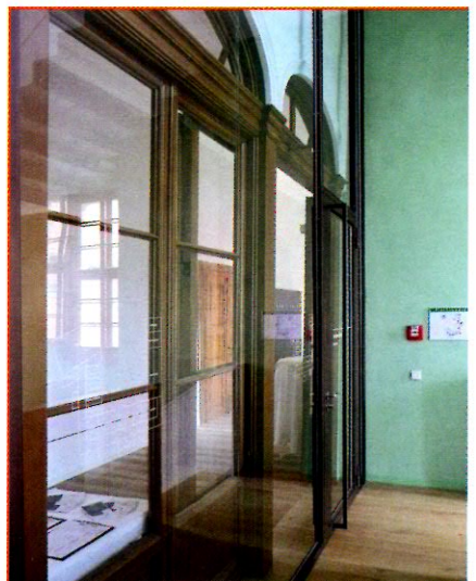
Abb. 4: Brandschutzverglasung vor historischer Tür
