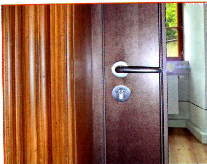
Abb. 6: An die vorhandene Leibungsbekleidung angepasste Brandschutztür
