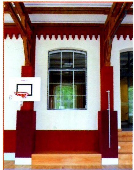
Abb. 2: Jede – auch transparente – Maßnahme ist beim Baudenkmal eine Beeinträchtigung.
