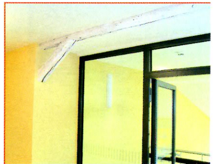
Abb. 3: Die konkrete Einbausituation ist insbesondere beim Baudenkmal zu beachten.
