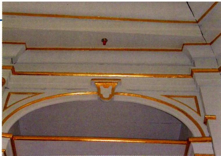
Feuerwehr. Wasserebellöschanlagen verhindern mit Einsatz nur geringer Wassermengen die Brand- und Rauchausbreitung. Selbst Lehmwickel in einer Holzbalkendecke bleiben bei Einsatz der Wasserebellöschanlage erhalten und müssen nicht – wie nach einem Löschangriff der Feuerwehr bei einem Vollbrand – entsorgt werden.
